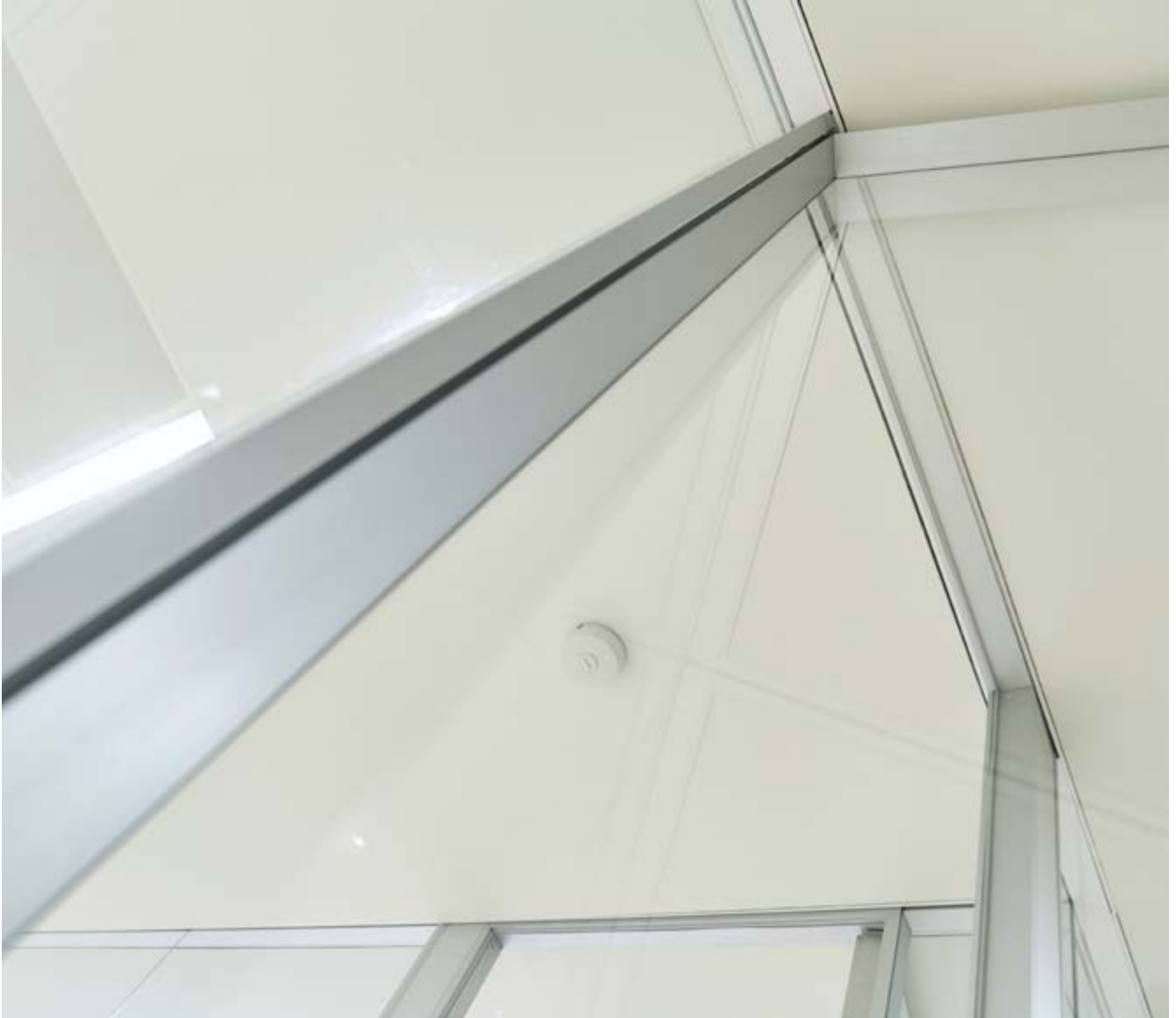
detalle de las mamparas integradas en el falso techo
