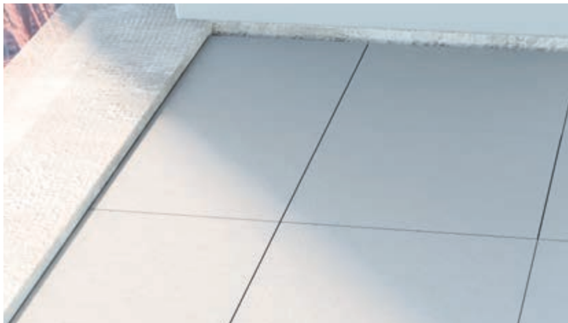
Posizionamento pannelli allineati e livellati
