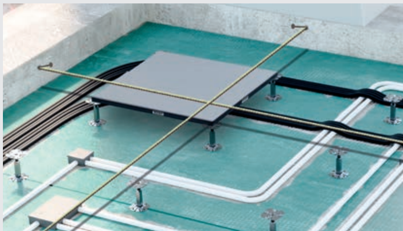
Posizionamento primo pannello con utilizzo dei due fili ortogonali
