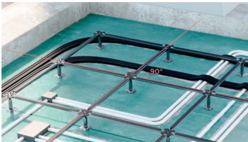
Verifica angolatura a 90°
