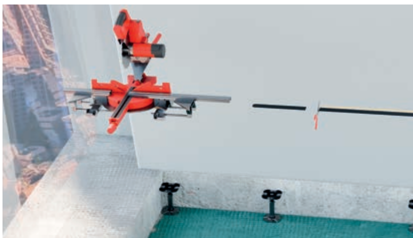
Taglio traversi e guarnizioni perimetrali
