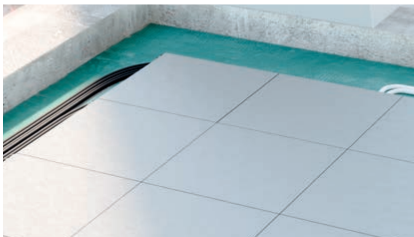
Posizionamento pannelli allineati e livellati
