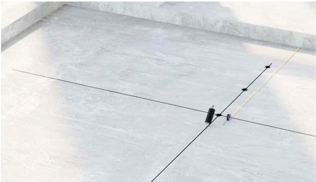
Contrassegno collocamento collonine con bomboletta spray
