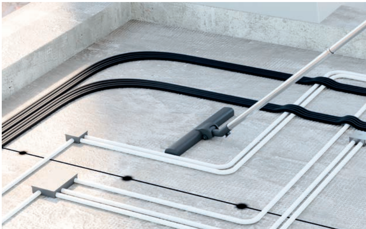
Pulizia ed aspirazione accurata della soletta
