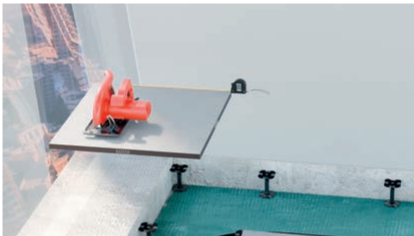
Taglio pannello perimetrale
