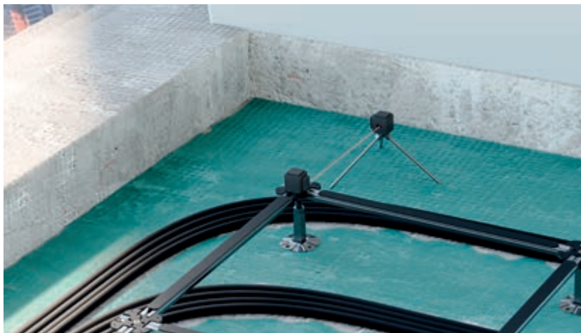
Utilizzo livella per posizionamento in quota delle colonnine
