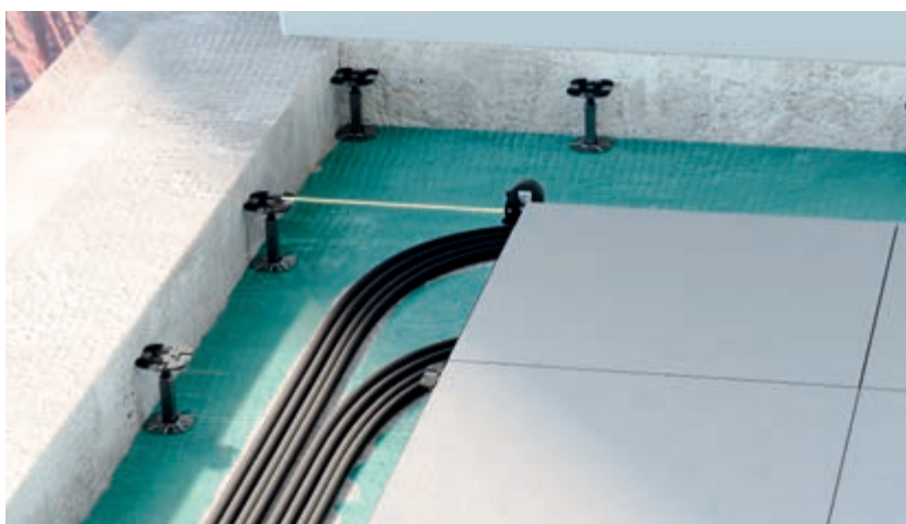
Misurazione distanza perimetrale
