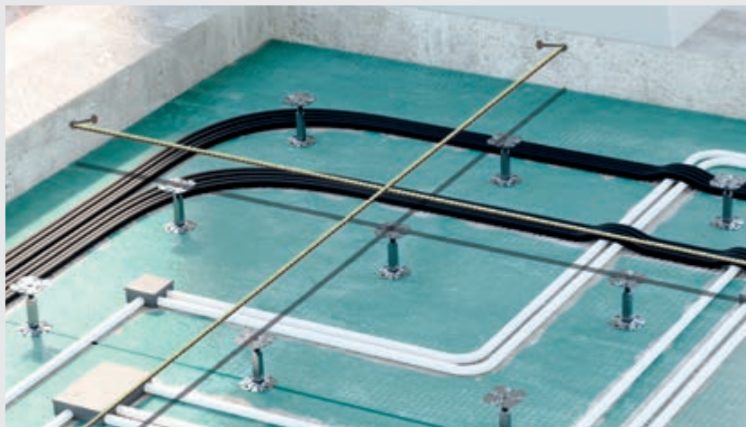
Allineamento con utilizzo dei due fili ortogonali
